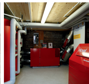
Esemplare soluzione ecologica in un complesso con edifici residenziali e commerciali: rete termica alimentata da una pompa di calore ad acqua di falda, ventilazione meccanica controllata con recupero di calore e umidità, e impianto fotovoltaico con SmartGrid.
