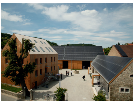
Esemplare soluzione ecologica in un complesso con edifici residenziali e commerciali: rete termica alimentata da una pompa di calore ad acqua di falda, ventilazione meccanica controllata con recupero di calore e umidità, e impianto fotovoltaico con SmartGrid.
